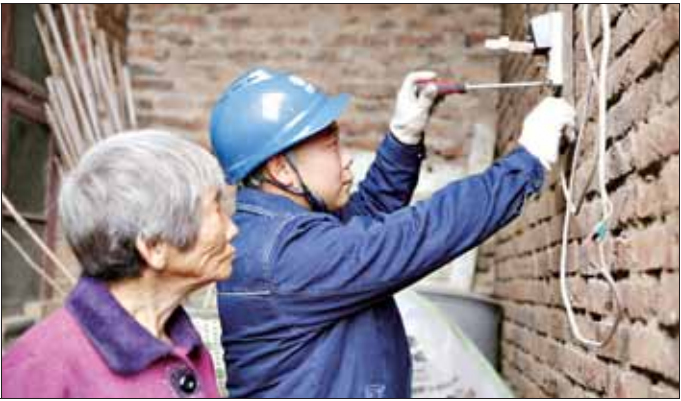
电力人员为龙宫村村民检修线路
