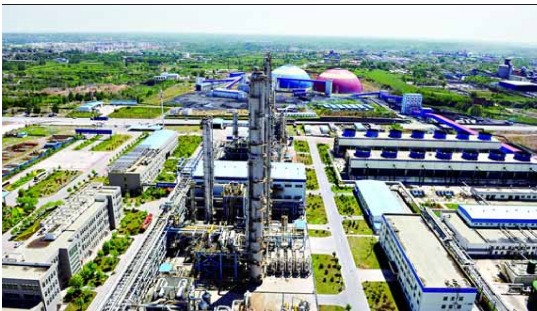
位于宝山循环经济产业集聚区内的年产60万吨甲醇项目空气分离区。 资料照片
