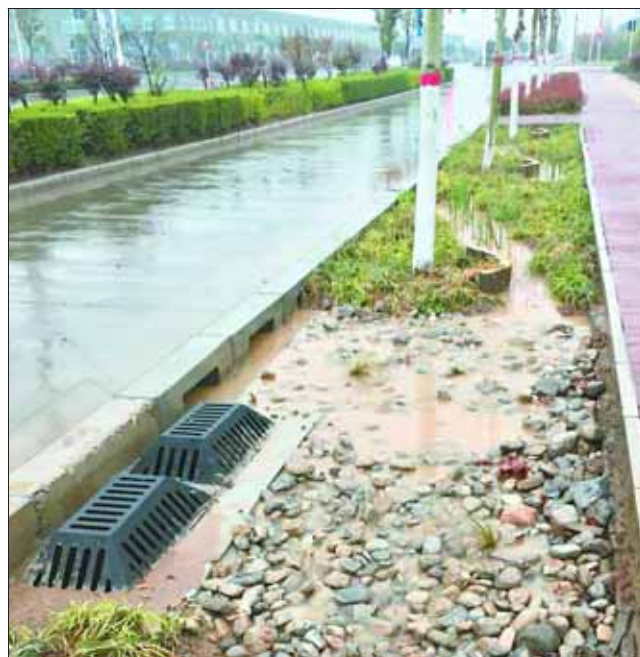
通过道牙石开口，泰山路路面雨水汇入生物滞留带内，逐步净化、下渗。
