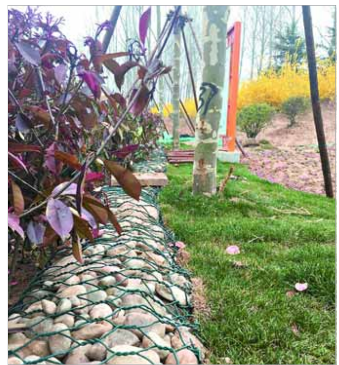
淇水乐园路侧石笼装满了鹅卵石,不仅可减缓水土流失,而且会起到净化、过滤雨水的作用。
