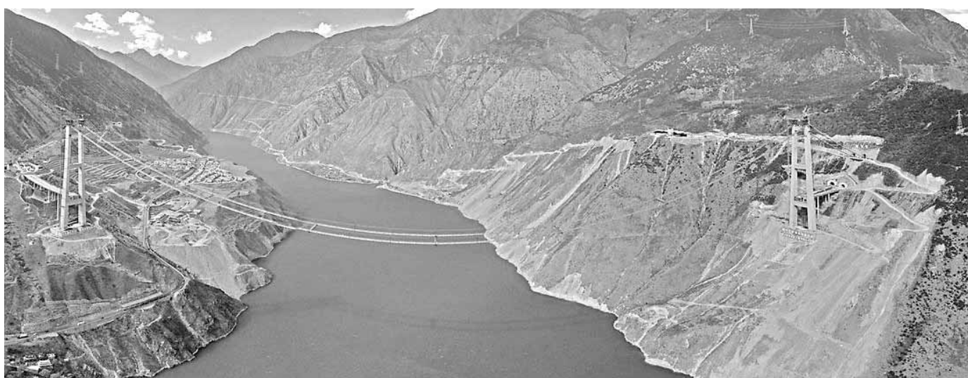
雅康高速公路(四川省雅安市至康定市)重点控制性工程、被称为“川藏第一桥”的泸定大渡河兴康特大桥,5日成功架设首根主缆索股,标志该桥上部构造主体工程施工正式启动。预计全桥主缆将在今年8月完成架设,2018年8月底全桥建成贯通。(据东方IC)
