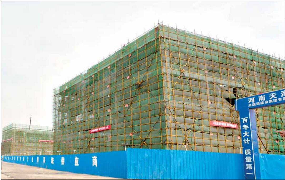
位于鹤壁国家经济技术开发区的天海工业园项目,总投资20亿元,规划建设厂房、办公楼、研究院及配套设施近20万平方米,用于实施新能源汽车线束、新能源电机和控制系统、汽车电子等项目的开发建设。项目分两期建设,目前正在建设的是一期工程。
