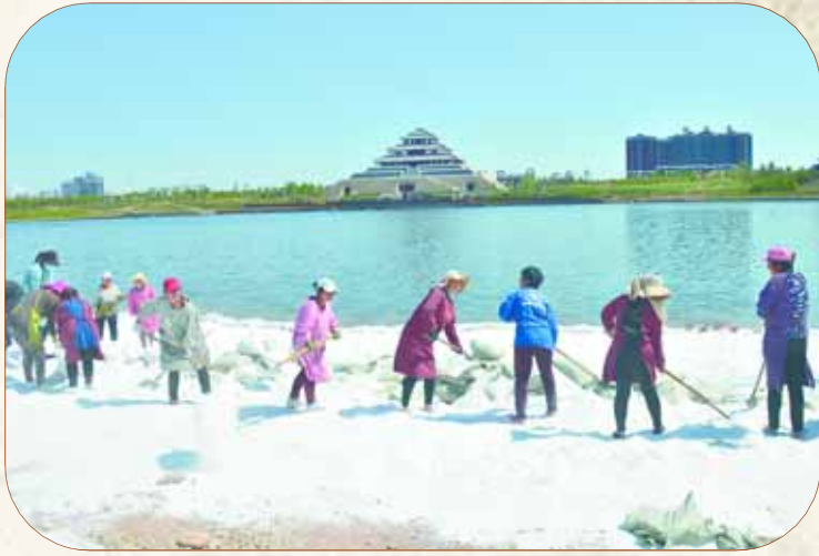
正在施工的银沙滩
