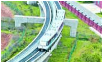
5月6日，中国首条中低速磁浮铁路——长沙磁浮快线安全试运行一周。
