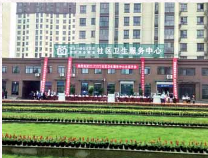
市城乡一体化示范区淇水湾办事处社区卫生服务中心
