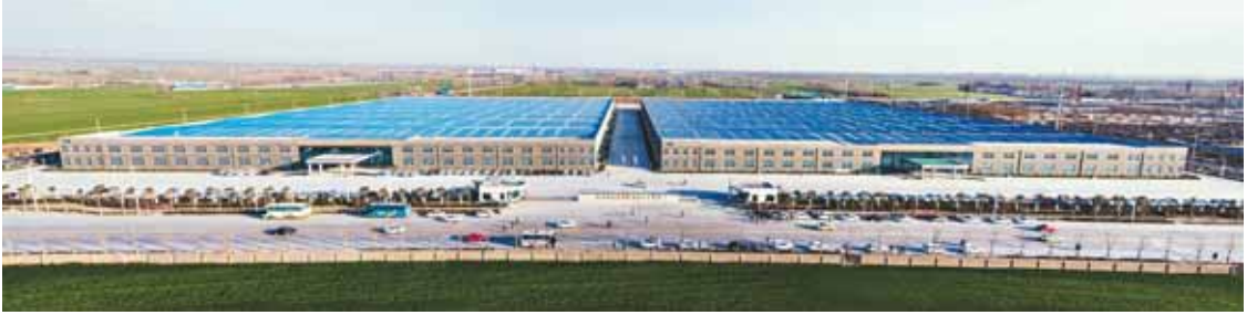
天海集团国际高端线束出口工业园。
