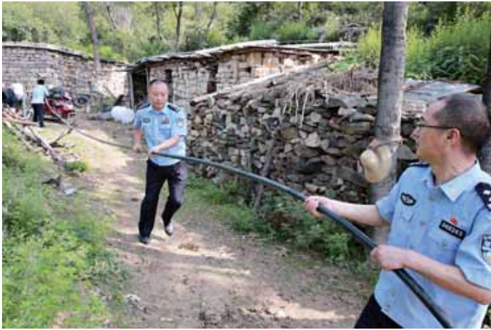
民警为梁喜姐家架设水管。
