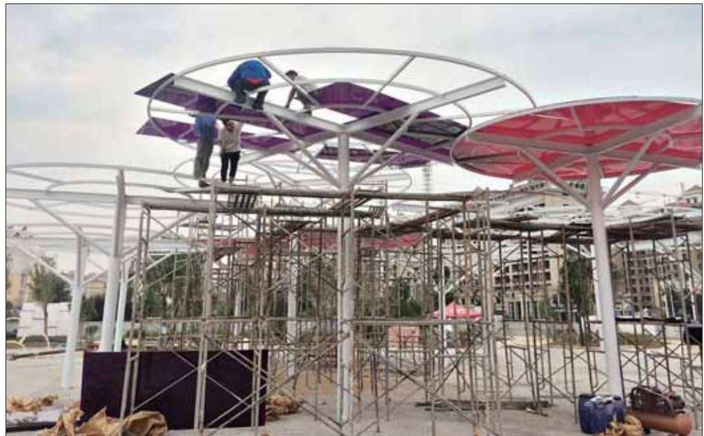
图为工人在搭建供游人休息的亭子。
