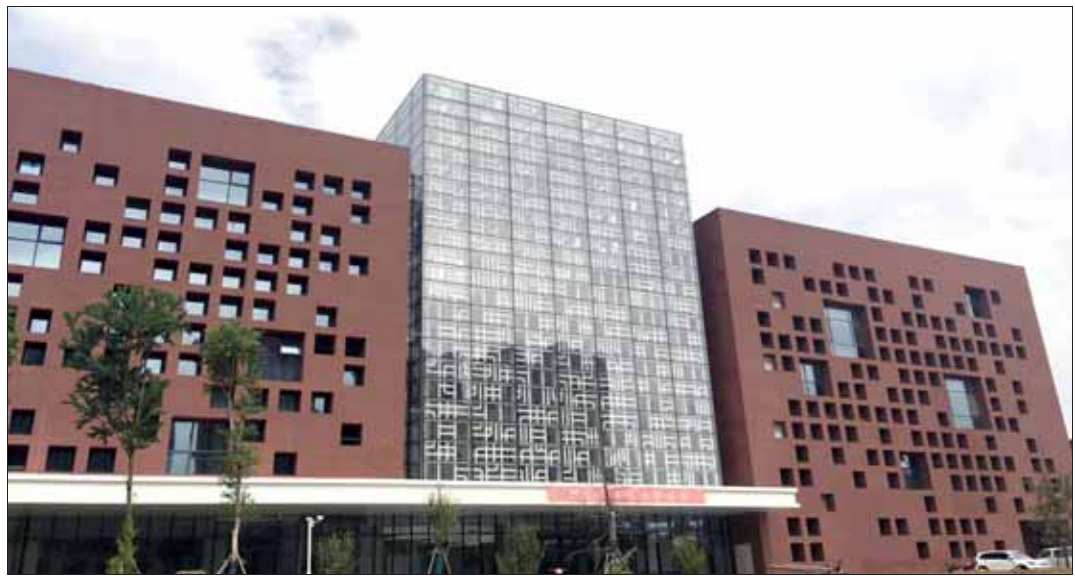
双层墙体、隔热玻璃……按照绿色建筑标准建设的市图书馆新馆体现了绿色低碳理念。
