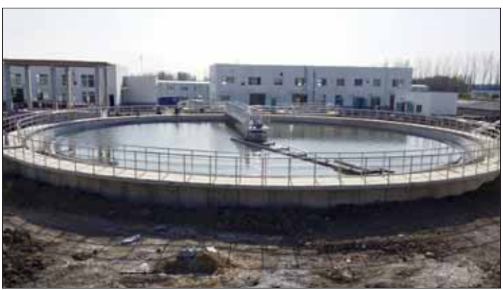
淇县县城污水处理中心扩建日处理3万吨污水工程,是省、市、县重点民生项目。
