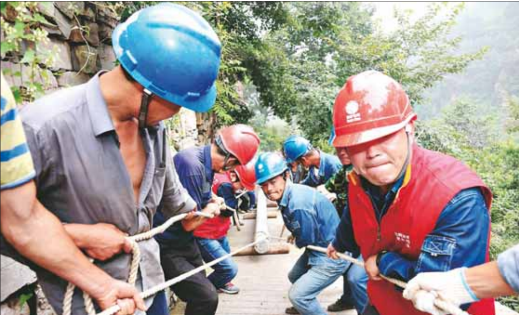
2016年8月,国网淇县供电公司党员服务队在为石桥村将1吨重的电杆人工运上山。佟玮芳 摄(资料图)
