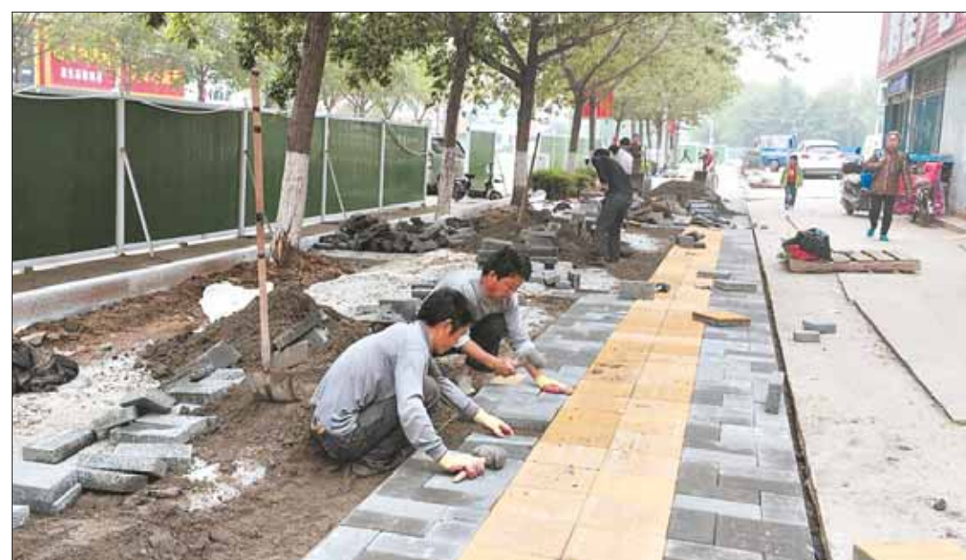
4月28日,施工人员在淇滨区华山路北段人行道铺设透水砖,日前铺设工作已完成。本报记者 王帅 摄
