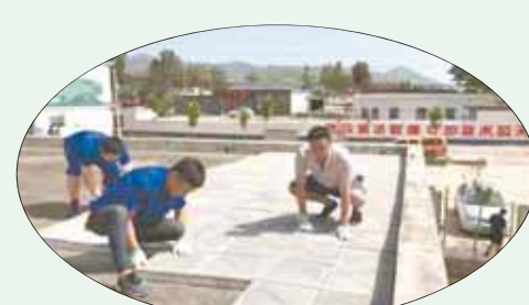
施工人员在屋顶安装保温一体化板。
