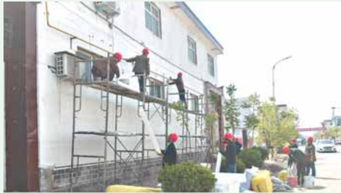
施工人员在淇滨区钜桥镇岗坡村对农房外墙进行保温改造。
