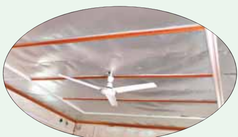
安装了橡塑保温棉的农房室内顶部。
