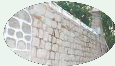
山区典型的石头外墙平屋面农房。
