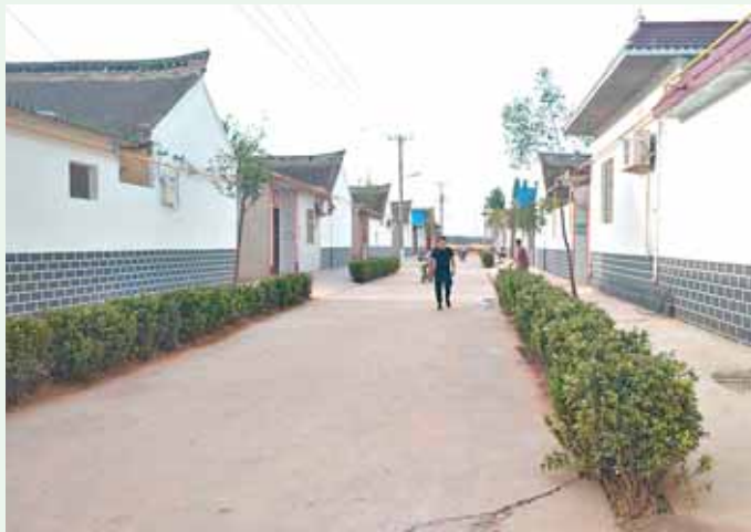
淇滨区大赭店镇田辛庄村房屋能效提升改造后的街景。
