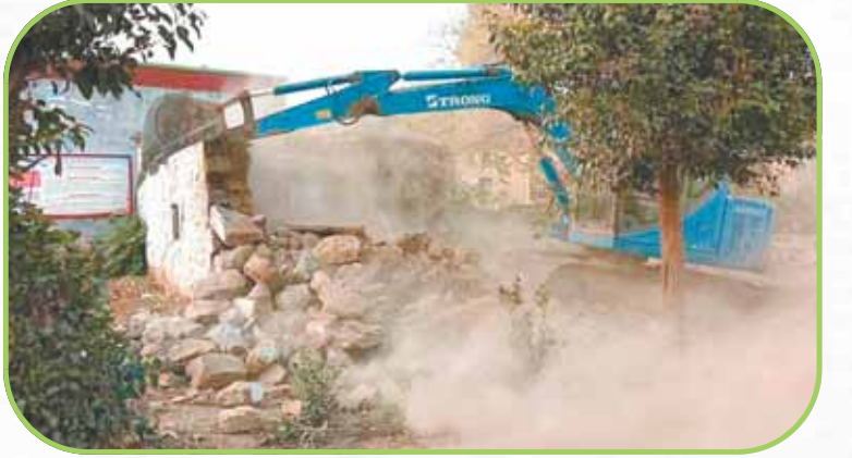
庙口镇东场村清理残垣断壁
