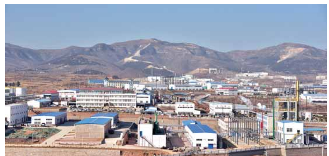
建设中的鹤山区姬家山产业园。
