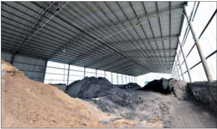
位于浚县伍山街道东张庄村的恒大墙体材料有限公司的物料仓库进行了密闭,有效抑制了扬尘污染。
