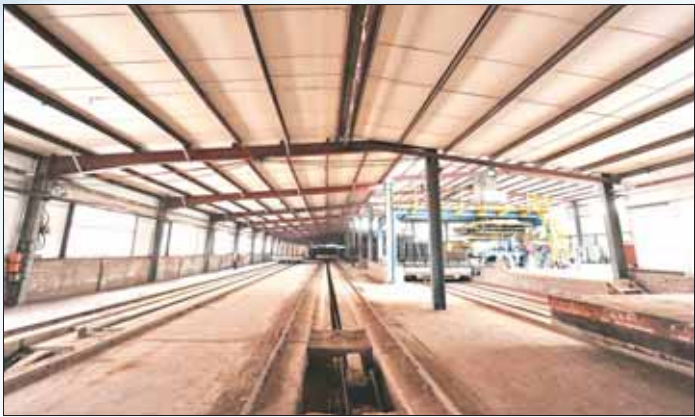
位于浚县伍山街道东张庄村的恒大墙体材料有限公司的隧道窑均进行了有效密闭。
