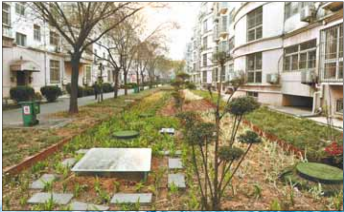
经过海绵化改造的淇滨区三和佳苑小区绿化带内设置了雨水花园,可通过植物、沙土的综合作用使雨水得到净化,并使之逐渐渗入土壤,涵养地下水。
