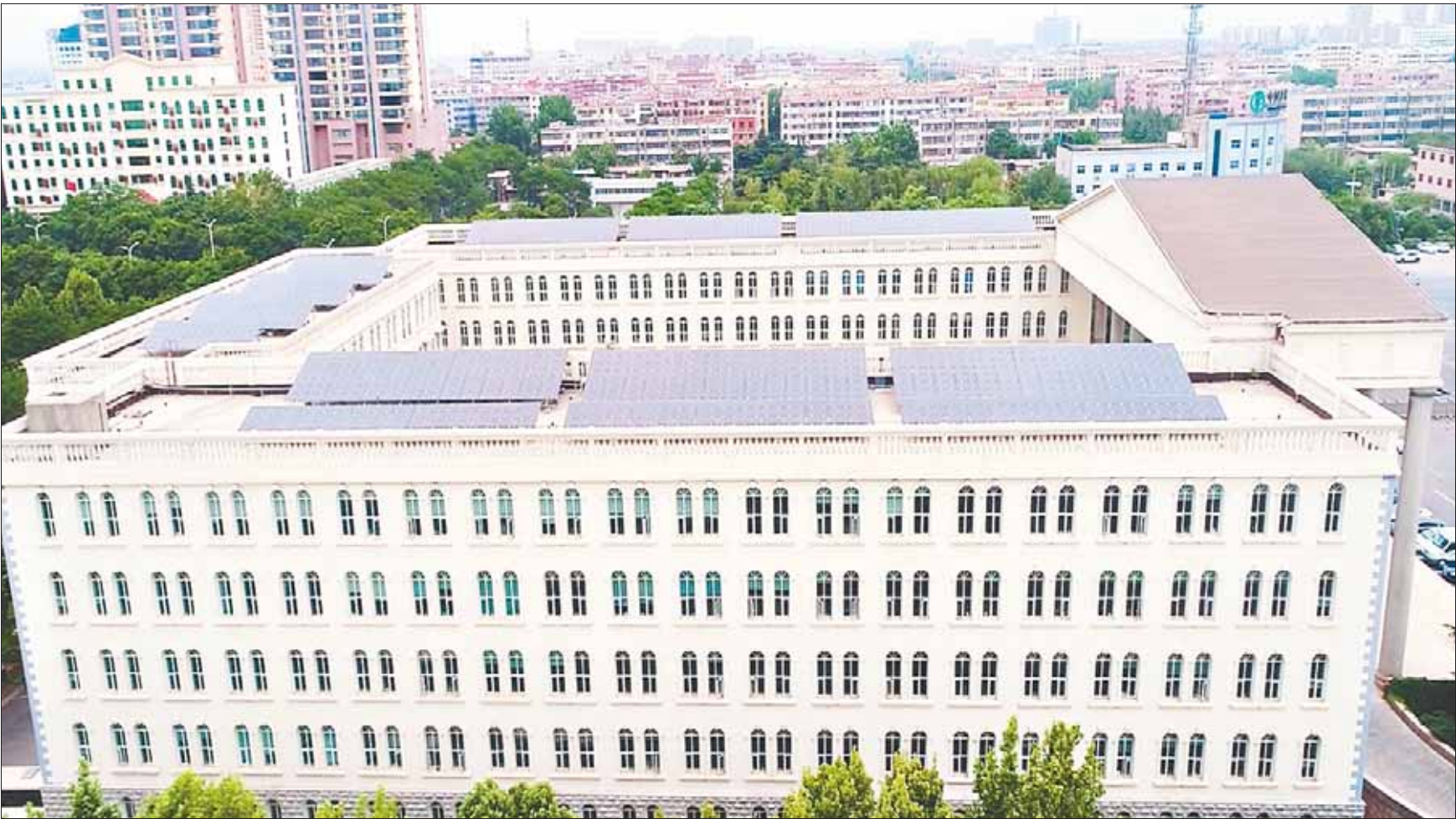
通过合同能源管理项目引入社会资金,在市委市政府合署办公区第二综合楼建设了2个屋顶太阳能光伏电站,年发电量约25.9万度。
