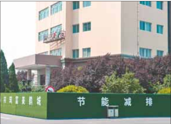
市委市政府第一综合楼在进行节能提标改造。
