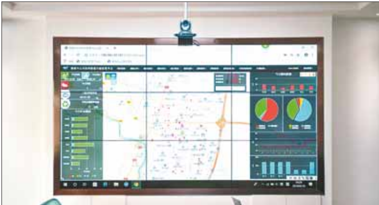
全市公共机构智慧节能监测管理系统实时监控全市763家公共机构的用水、用电情况。
