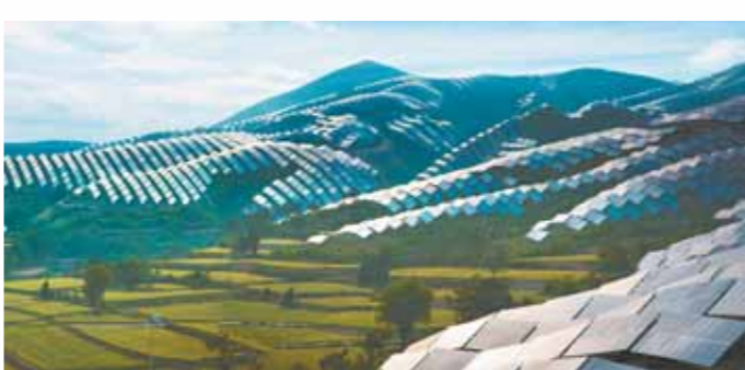
位于淇县岳口镇土门村，形如彩虹近山上的光伏发电项目，年发电量达5000万千瓦时，每年可节省2.16万吨标煤。
