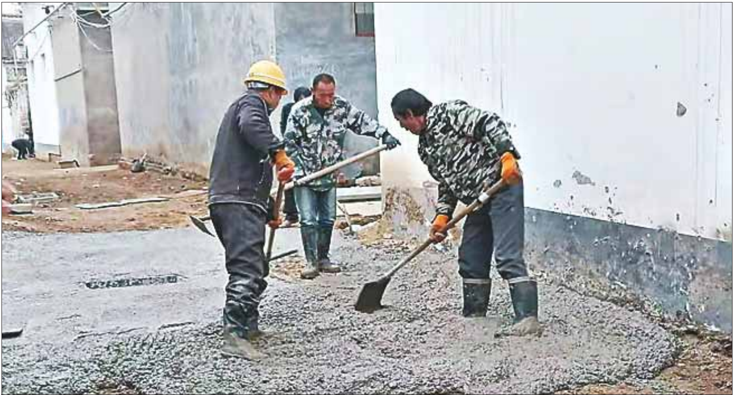
淇水湾街道姬庄村正在硬化村内道路。
