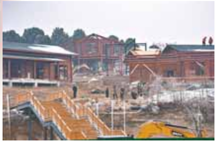
岗坡村龙脊山上的火锅城正在建设。
