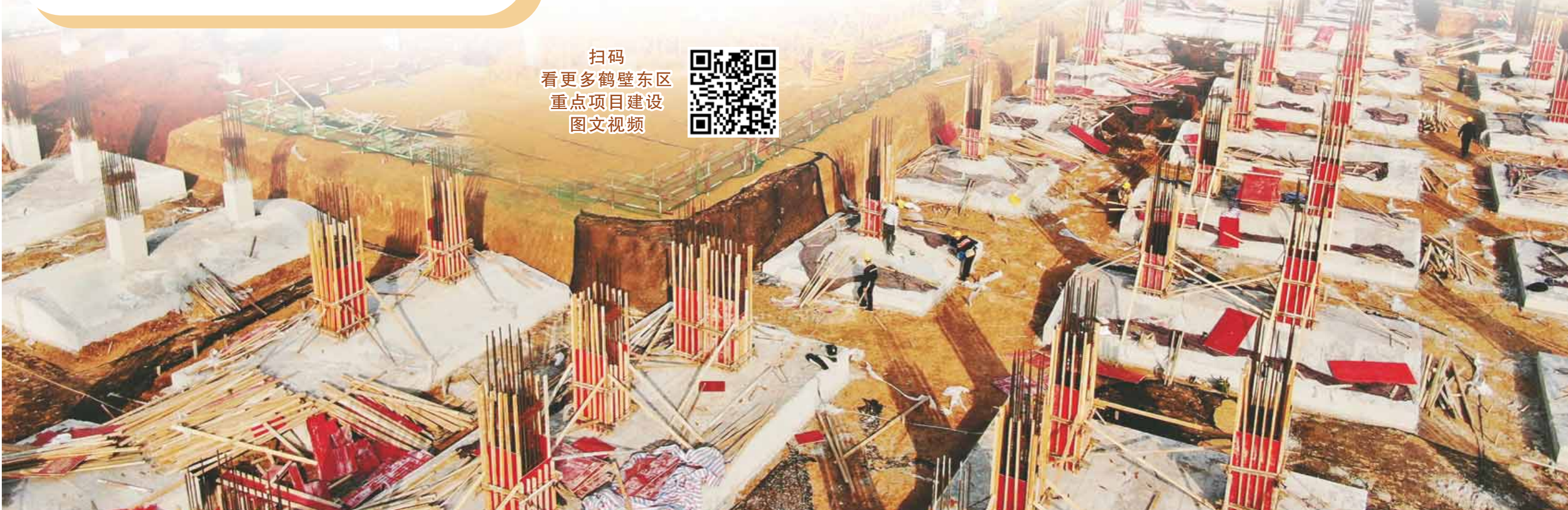
天籁学校项目施工现场。
