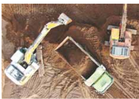
5G产业园A区项目:施工单位正在进行土方清运。
