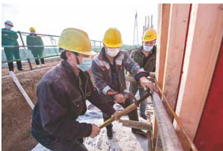
天籁学校项目:工人进行基础柱钢筋、模板施工。
