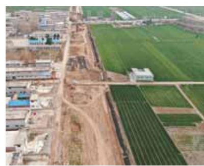
天籁大街项目:施工单位正在开挖北标段东侧雨水管沟槽。
