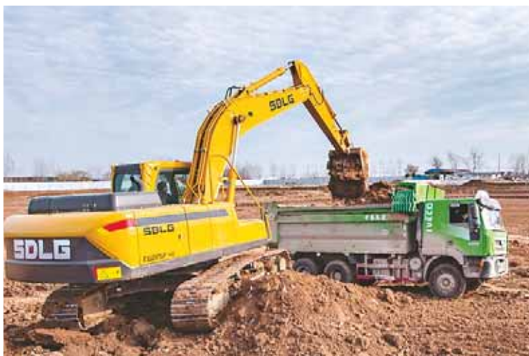
水系改造披烟园项目工地:施工单位正在对弃土场第13层做回填及微地形整理。
