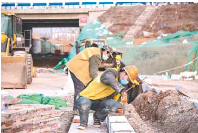
柳江路下穿高铁高速项目:工作人员正在施工。
