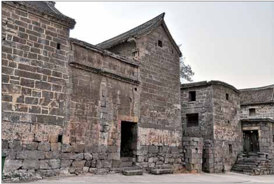
温坡村的石头房墙面工整,均由大小不一的青色方石垒成,有的方石重达千斤,很有气势。图为该村杨家大院。
