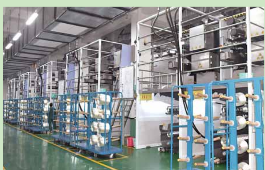
中维化纤股份有限公司安全气囊生产车间。
