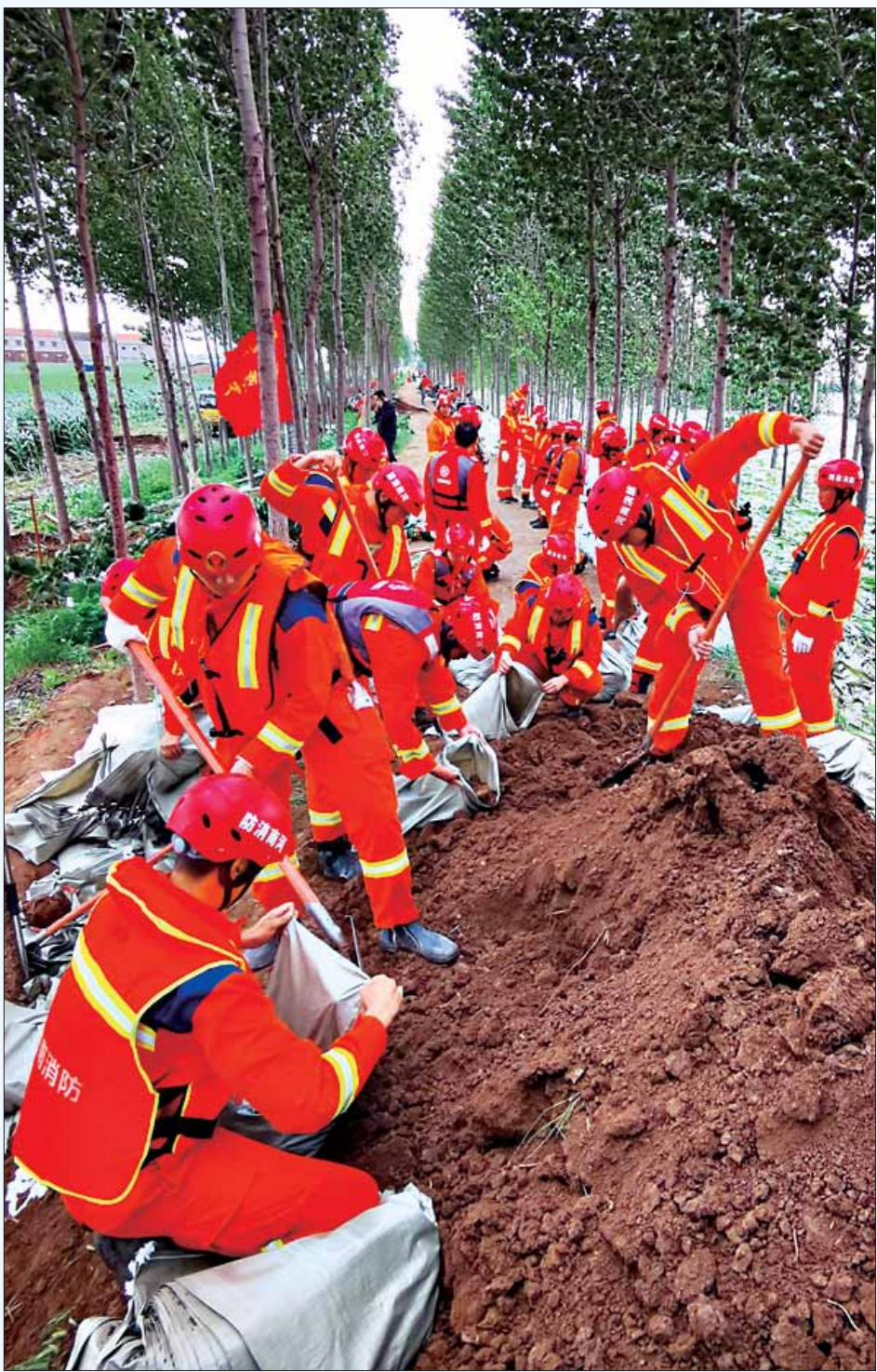
7月29日,浚县傅庄堤花地新村段,市消防救援支队指战员正在加固堤坝。
