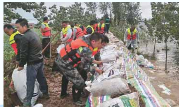
并肩人民子弟兵,理峪村边固河堤。
