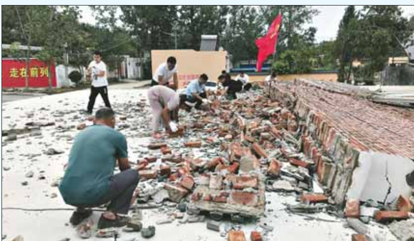
山城区发改委防汛帮扶工作队在西酒寺村清理倒塌文化墙。
