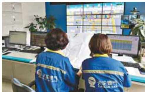
调度中心通过信息化平台密切监控管网压力,出现异常立即通报。
