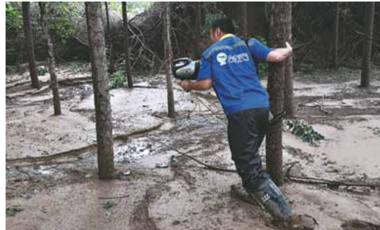
暴雨过后,巡检人员在泥泞中排查燃气管线安全隐患。
