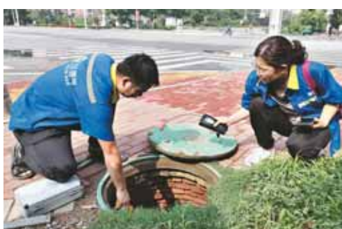
暴雨过后,网格员巡检片区内的阀门井,进一步排查安全隐患。
