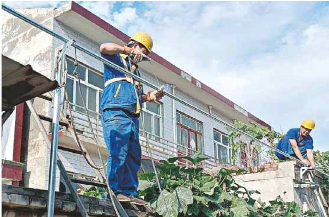
抢险人员对农村天然气漏损管网进行抢修。
