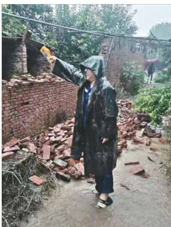
巡检人员在暴雨中对坍塌墙体附近的燃气管网进行漏气检测。
