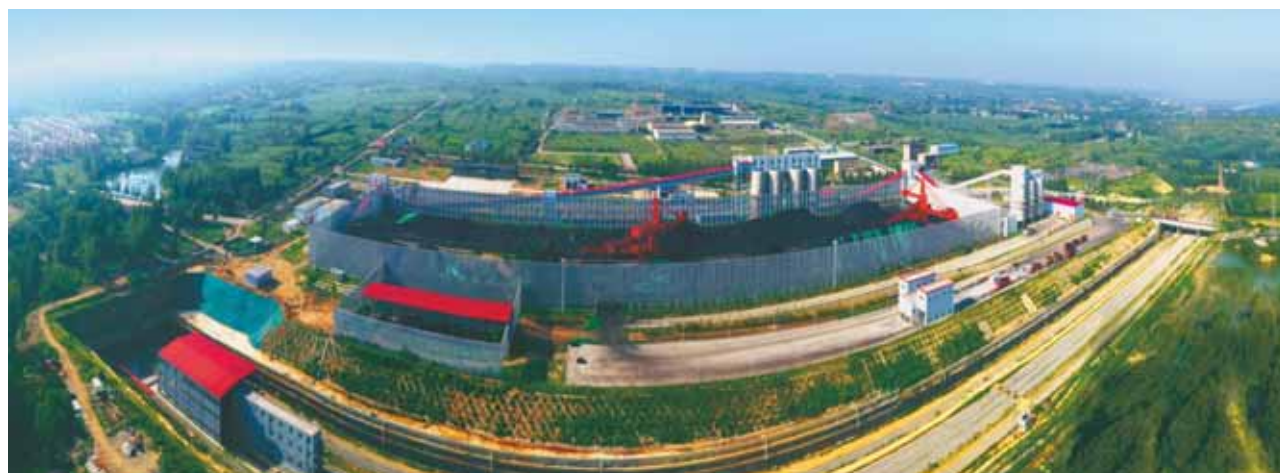
鹤山区韩林润产业园内的河南煤炭储备交易中心煤炭物流园已经建成数字化煤场,实现了煤场动态数字化管理。
