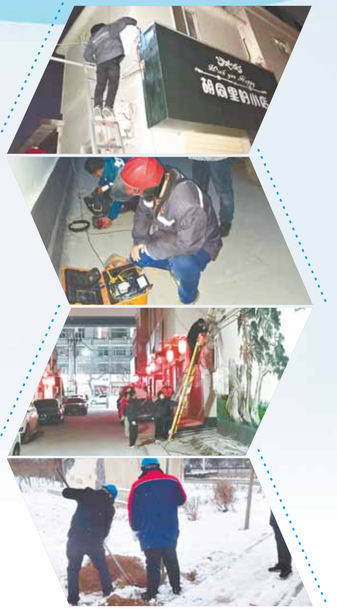
鹤壁联通淇县分公司组织施工队伍克服寒冷天气影响,上杆路、穿管道、熔光纤、接设备,圆满完成了通信网络灾后恢复重建百日会战目标任务。图为施工现场。鹤壁联通淇县分公司供图
