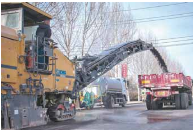
定浚线(浚县段)施工现场。浚县公路管理局供图
