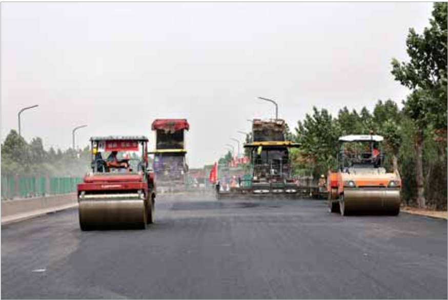
鹤壁快速通道施工现场一派繁忙景象。
