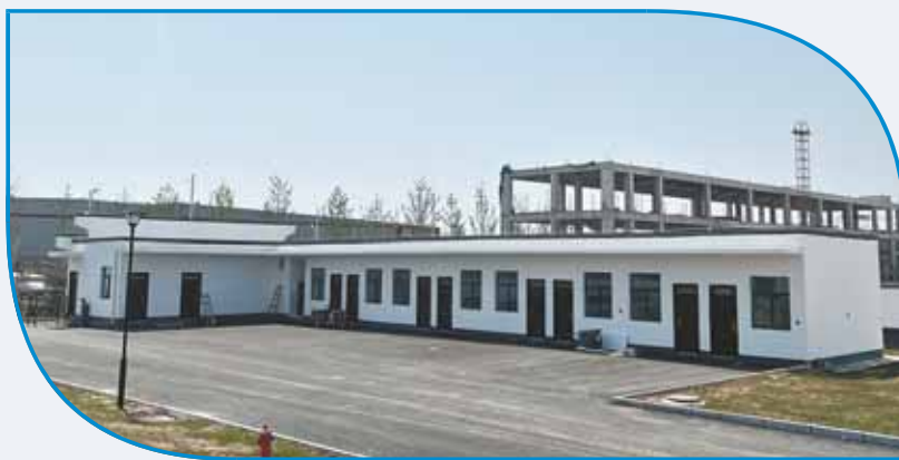
鹤壁科创新城配套工程白寺水厂建设已完工,预计今年下半年投入使用。
