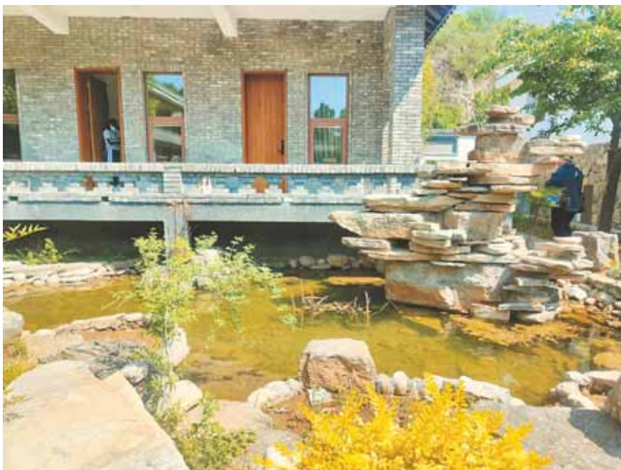
山泉串串儿、景色秀美的黄洞乡鲍庄村引进开发公司,升级改造村民闲置住房,开发高端民宿,打造鲍庄康养基地。图为鲍庄康养基地一角。
