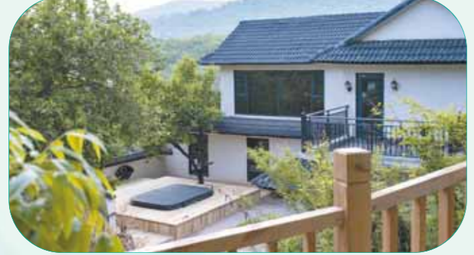
鹤山区半日闲温泉康养基地项目
