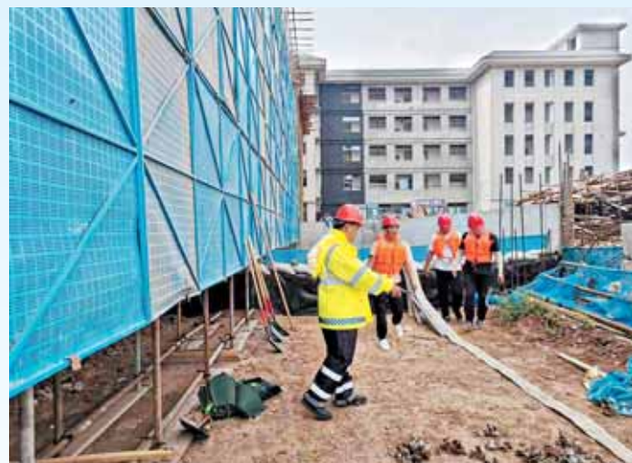
演练人员正在铺设抽水泵水带。 本报记者 李丹丹 摄
