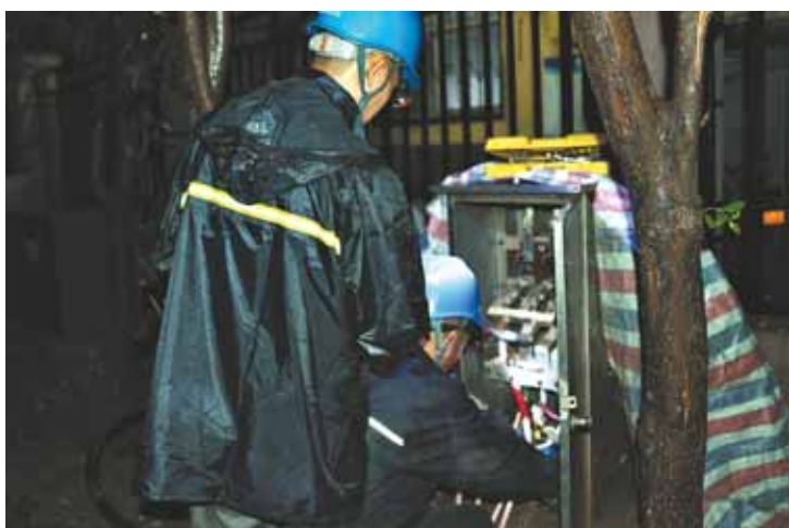
7月5日晚,暴雨如注,淇滨区红枫巷地理电缆发生故障。国网鹤壁供电公司抢修人员第一时间前往故障点进行抢修,全力保障群众夜间用电正常。
