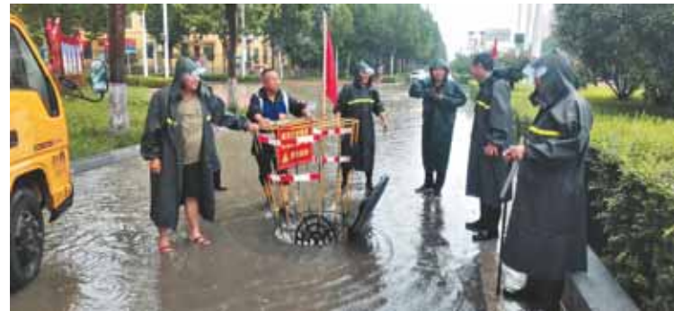
7月5日下午,示范区公用事业发展中心工作人员在城区街道打开雨水井盖,安放防坠笼,加快雨水排放。
