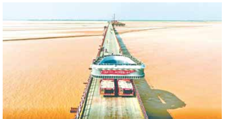
图为该项目首节索塔完成吊装现场(7月11日摄)。河南日报记者 王铮 实习生 刘若琪 摄
