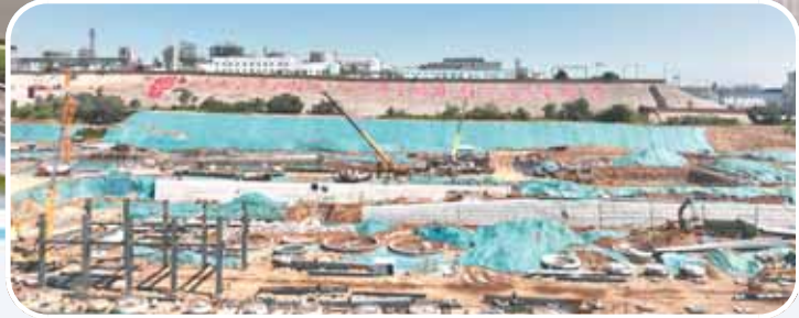
鹤壁龙宇新材料有限公司项目建设如火如荼。
