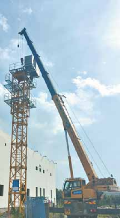
图为河南越汇食品科技有限公司年产5万吨火锅调理肉制品项目建设现场。
