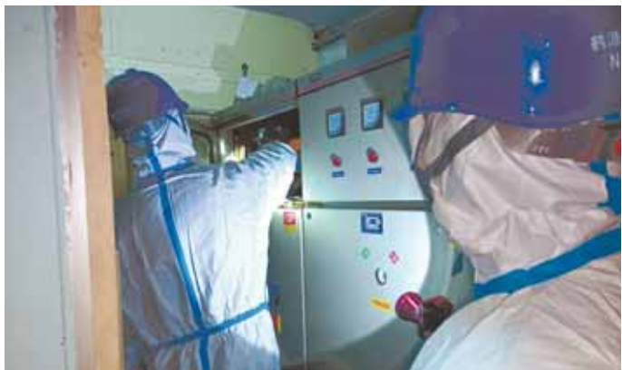
国网鹤壁供电公司抢修人员“全副武装”处理故障。贾志强 摄
