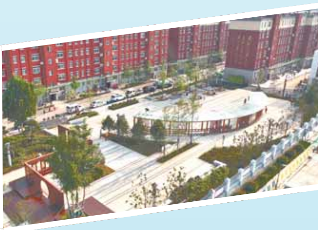
升级改造后的汤河桥街道馨苑二区。
