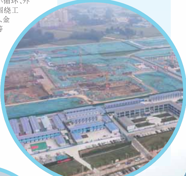
鹤壁工程技术学院新校区项目。
