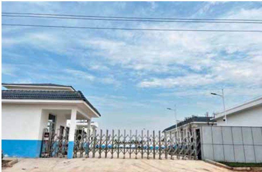
浚县小河镇水厂已完成建设任务,正在进行设备调试。图为浚县小河镇水厂厂貌。
