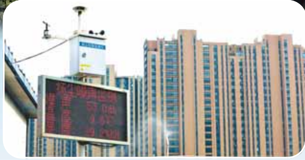
工地安装的扬尘在线监测仪实时监测温度、PM2.5、PM10等数值。
