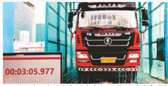
渣土车驶出工地前,至少冲洗3分钟,车身干净后才能上路。
