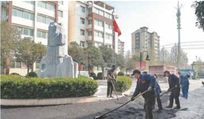
鹤壁淇县廉租房小区老旧小区改造提升项目施工现场。
